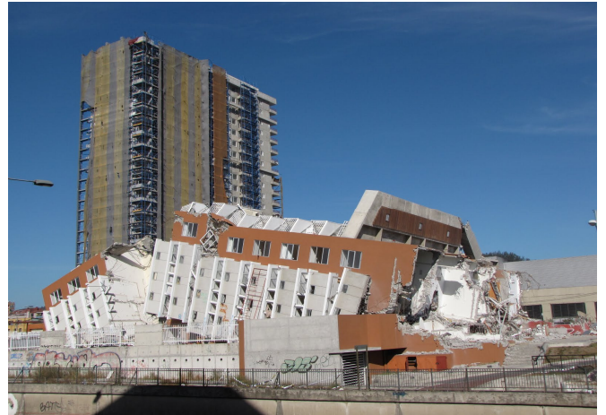
Foto 2. Acciones ilícitas para jerarquías inferiores de orden antrópico. Edificio derrumbado tras terremoto, Concepción, Chile
